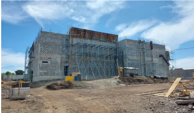
Avance edificio principal costado Oeste
