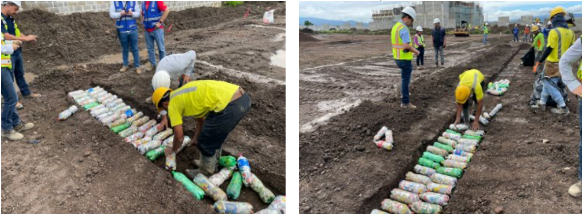
Fotografías 4.1 Proceso de colocación de ecobloques
