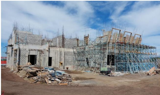
Avance edificio principal costado Este
