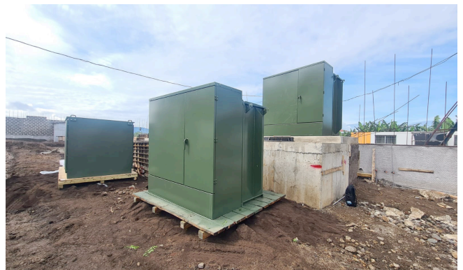
Llegada de equipos al sitio
