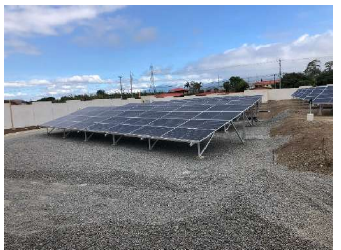
Colocación de piedrilla en terraza de paneles solares
