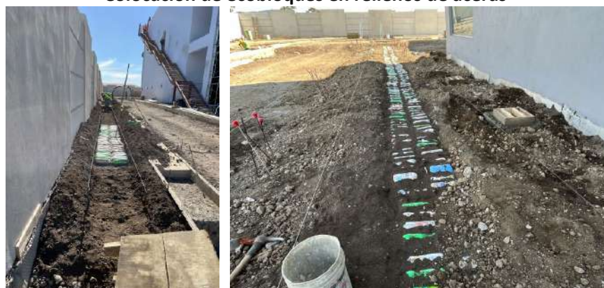
Fotografías 1.1 y 1.2 Colocación de ecobloques en rellenos de aceras
