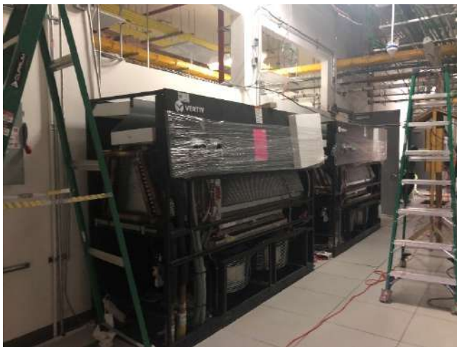
Equipos de aire acondicionado de precisión
