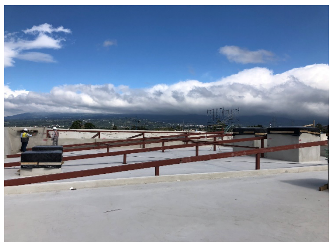
Estructura de cubierta de techo en azotea
